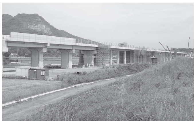
(梅林地区の高架橋)
