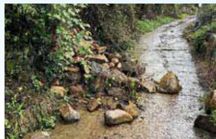
豪雨による被害
