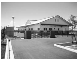
▲大開地区農業集落配水処理場
