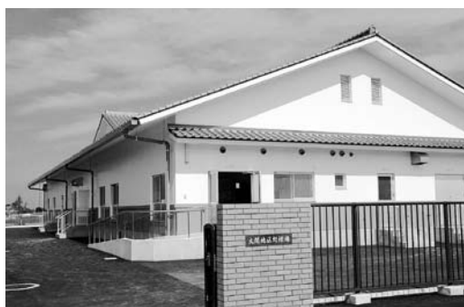
▲大開地区農業集落排水処理場
