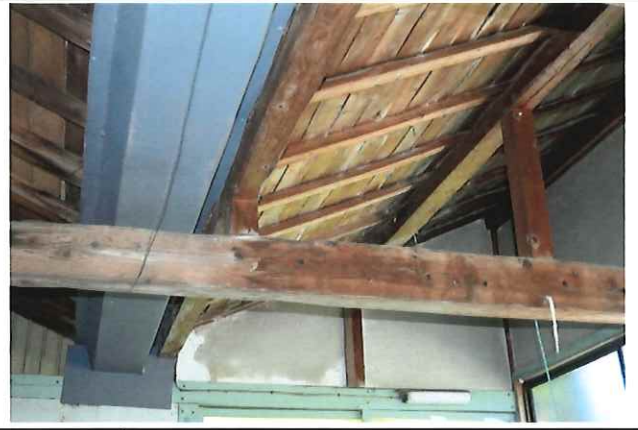
②⑥ ドマ 下屋と増築部との接合部の谷樋
