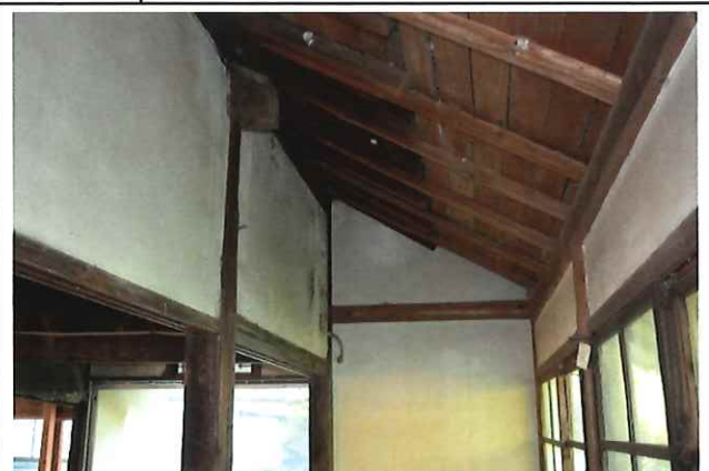
③② ドマ北側下屋の増築の痕跡
