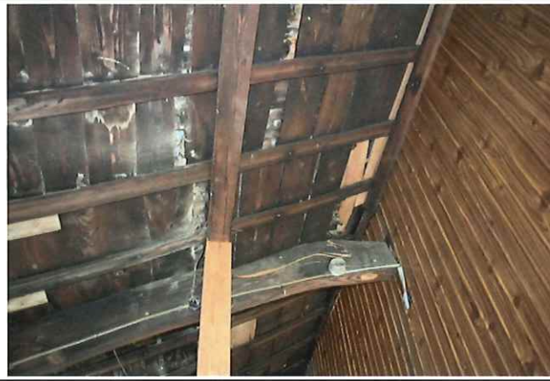
②⑤ ドマ下屋部天井 右は上屋の小壁
