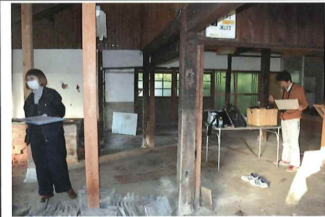
写真説明 詳細調査状況
