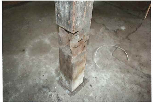
③⑩ ドマの柱に指物の痕跡(台所の改修)
