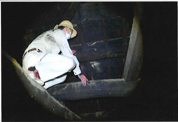
写真説明 小屋裏調査状況
