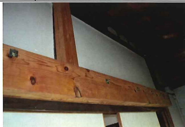
③① 北6畳縁2側指鴨居の補強
