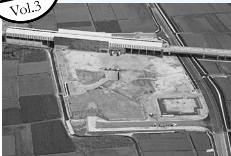
▲工事が進む駅前広場
