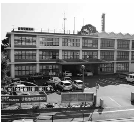
▲現在も未整備のまま放置されている旧庁舎
