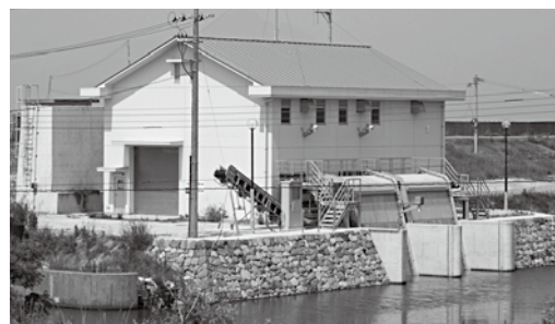
▲排水機場完成
