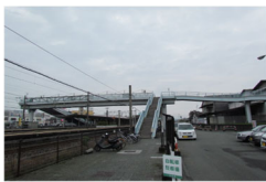
歩道橋(人道橋)
