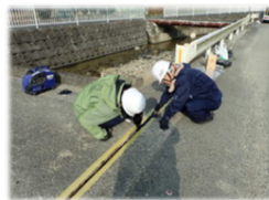
伸縮装置の漏水補修
