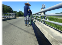
橋面端部の簡易橋面防水
