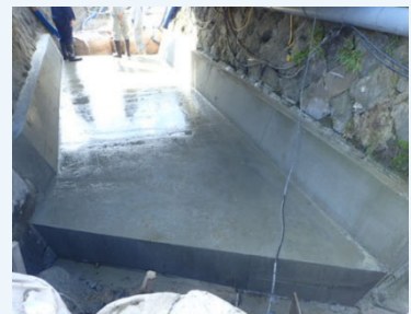
施工後の状況
