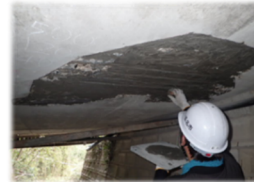
断面修復(左官工法)
