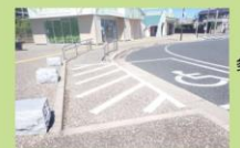
手すり・スロープ設置事例（吉富駅）
