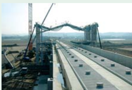
▲工事中の九州新幹線新玉名駅付近
