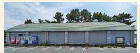
▲改修が予定される岱明磯の里
