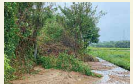
▲台風10号による被害
