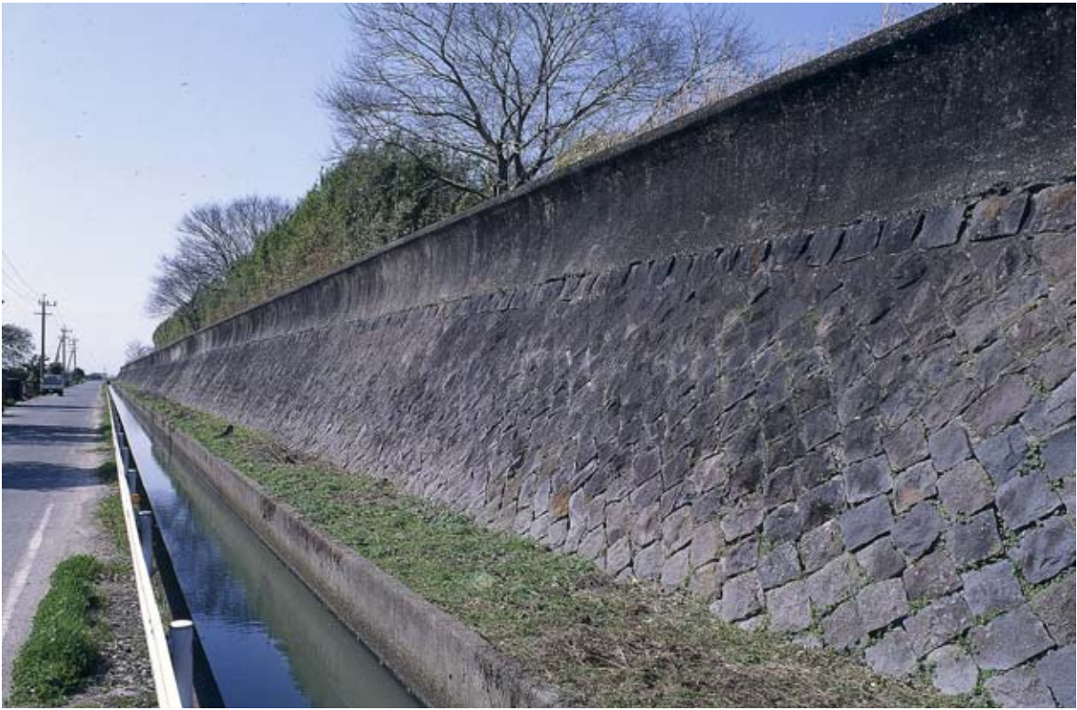
明豊開潮受堤防（東から）
