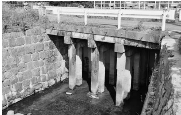
写真8 新井樋（西から）
