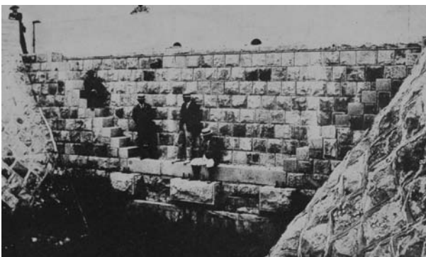
写真 14 潮害後の明豊開樋門海側 （『昭和貳年潮害誌』より）
