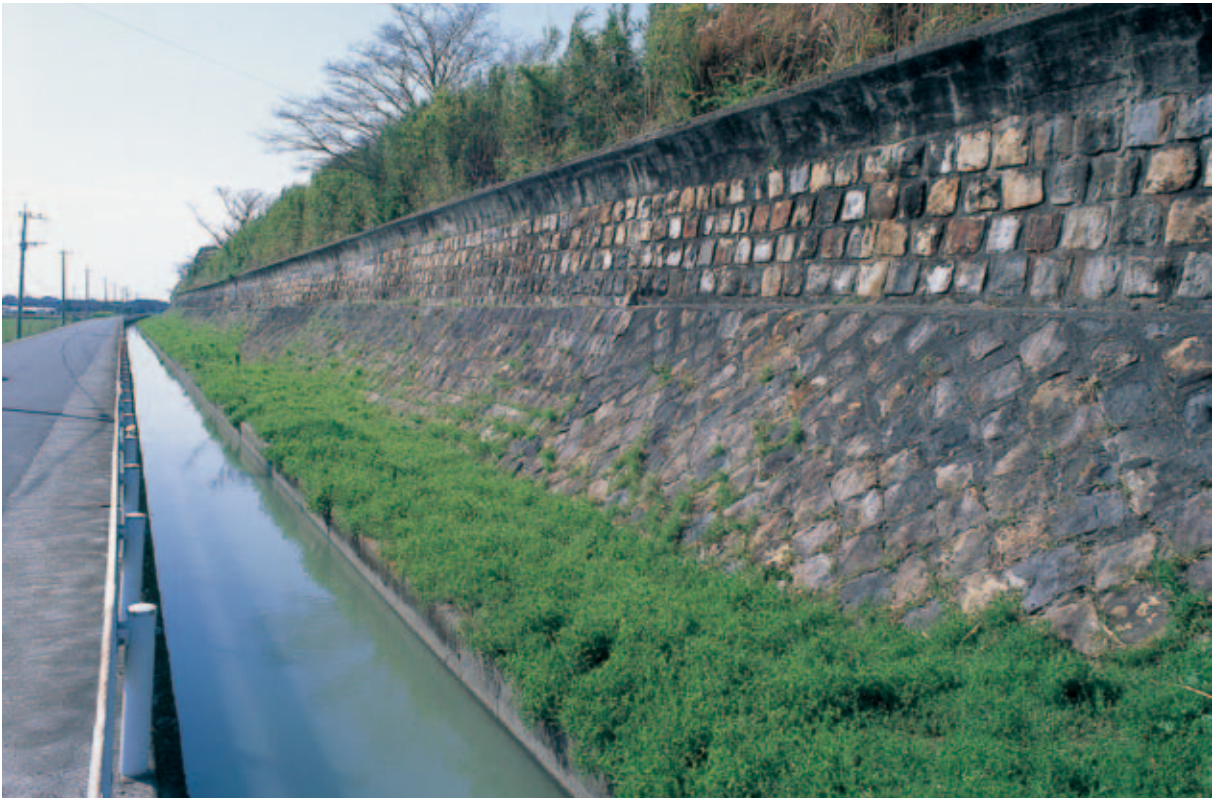
明丑開潮受堤防（東から）
