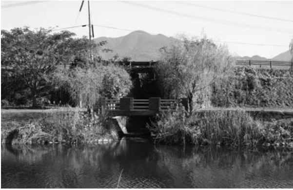
写真 23 十番開南側樋門海側（西から）
