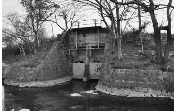
写真 17 明丑開樋門干拓地側（西から）
