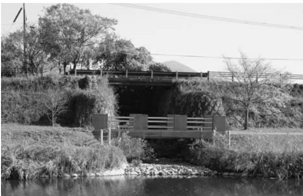
写真 20 十番開北側樋門海側（西から）
