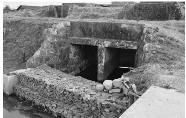
写真 19 六枚戸北側樋門干拓地側（北から）
