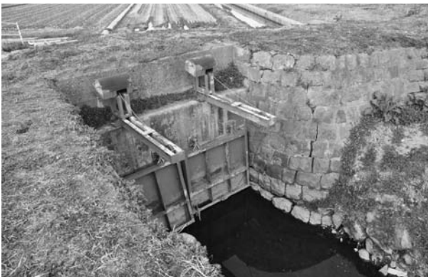
写真 18 六枚戸北側樋門海側（南から）
