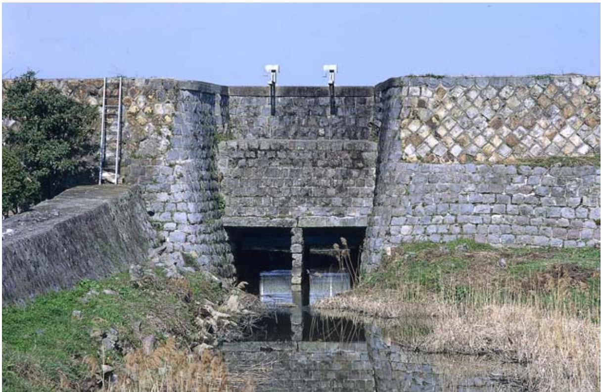
末広開二枚戸樋門（東から）
