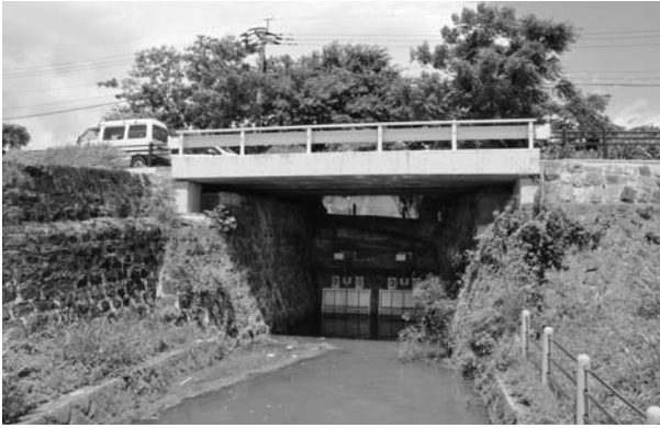
写真 16 明丑開樋門海側（東から）
