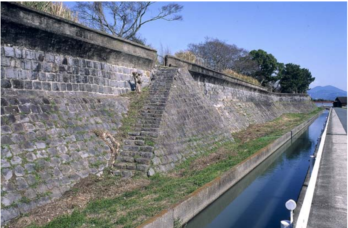
明丑開潮受堤防（西から）
