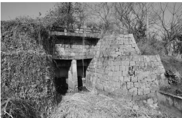
写真 21 十番開北側樋門干拓地側（東から）
