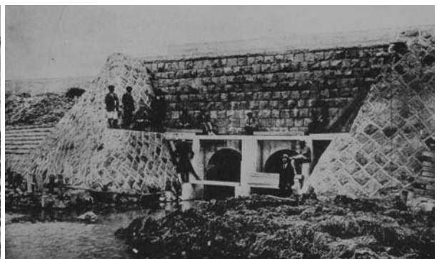
写真 15 潮害後の明豊開樋門干拓地側 （『昭和貳年潮害誌』より）
