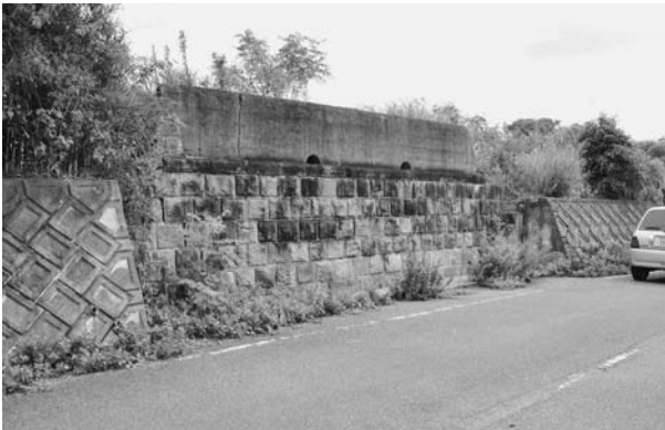
写真 12 明豊開樋門海側（西から）
