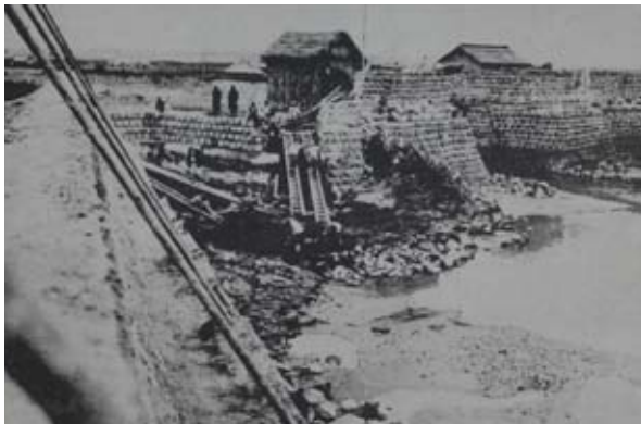
写真 1 末広開西三枚戸樋門周辺の復旧状況 （『昭和貳年熊本県潮害誌』から転載）
