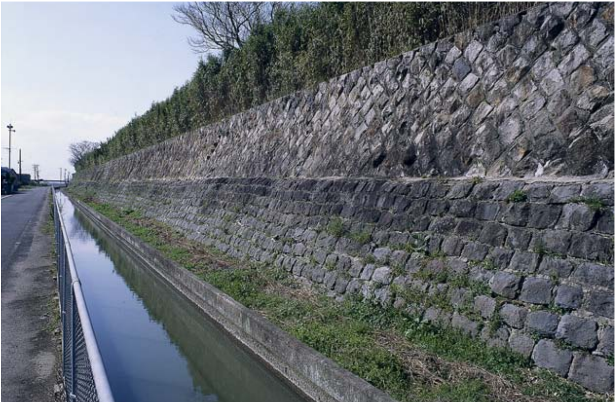
末広開潮受堤防（東から）
