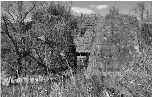
写真 24 十番開南側樋門干拓地側（東から）
