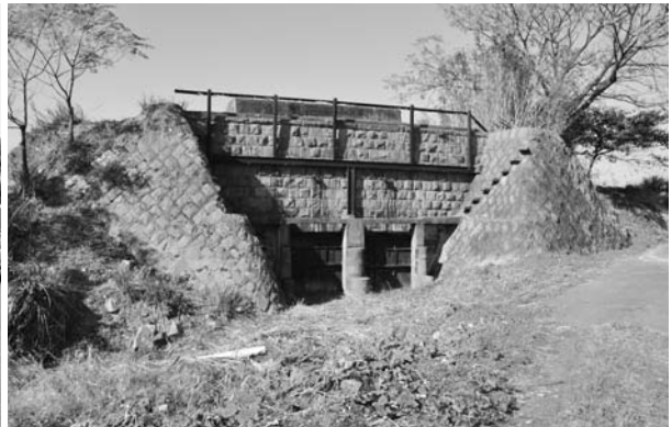
写真 13 明豊開樋門干拓地側（東から）
