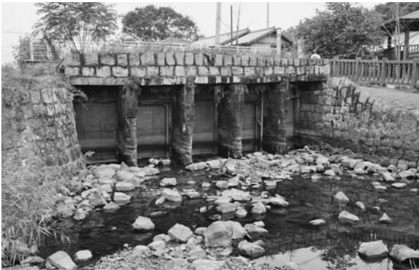
写真7 新内井樋（西から）
