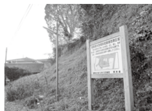
◀ 敷地内の土砂災害特別警戒区域
