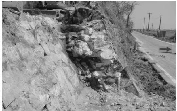
写真 61 末広開外側堤防石積み断面（西から）
