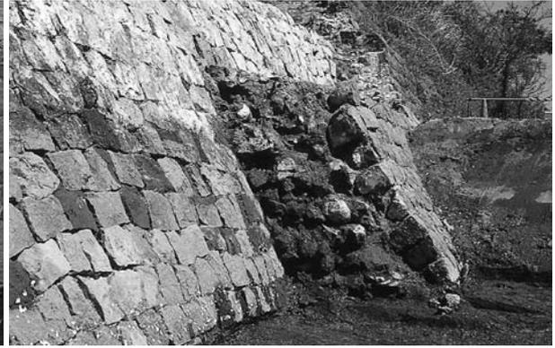
写真 64 末広開外側堤防下半部石積断面（西から）
