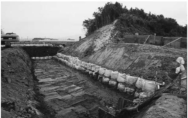
写真 74 水路工事掘削状況
