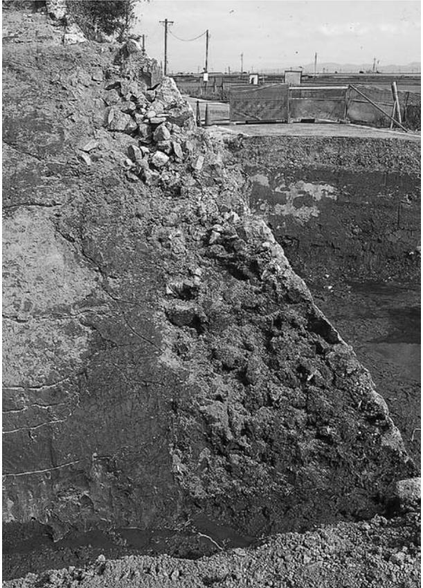
写真 70 末広開内側堤防石積み断面（西から）
