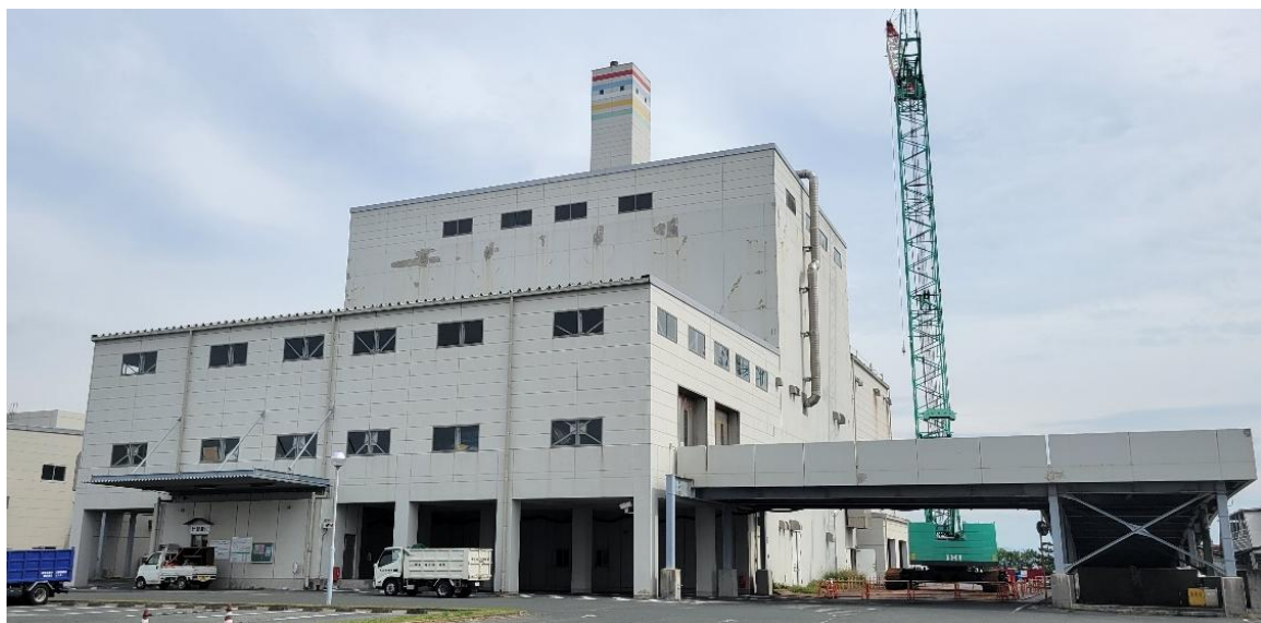
◆図 3-5-3 クリーンパークファイブ（ごみ焼却施設）外観写真
