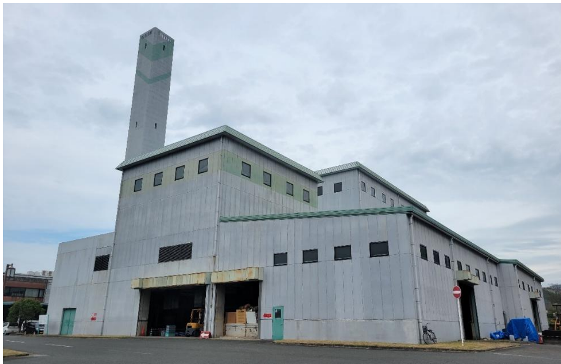
◆図 3-5-2 東部環境センター（ごみ焼却施設・資源粗大処理施設）外観写真
