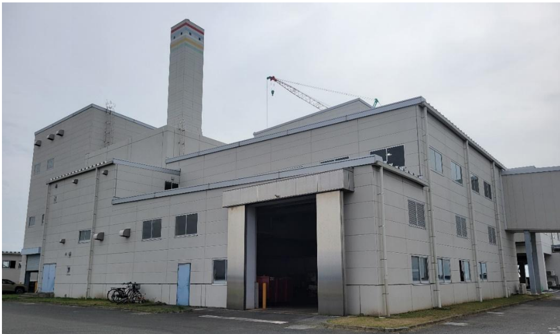
◆図 3-5-4 リサイクルプラザファイブ（リサイクル施設）外観写真
