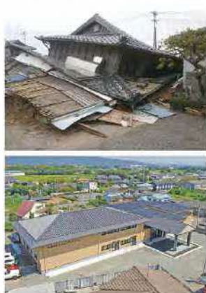
岱明防災コミュニティセンター 外観
