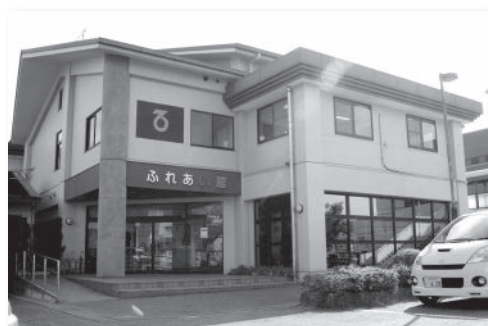
天水保健センターふれあい館
