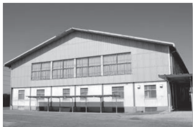
横島体育館（地域体育館）
