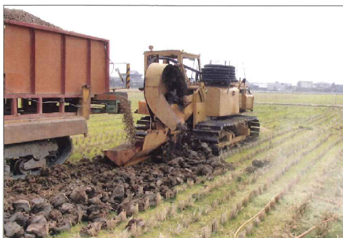
農業基盤促進事業(暗渠管の埋設)
