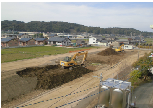
玉陵小学校(仮称)造成工事1期(西側)
