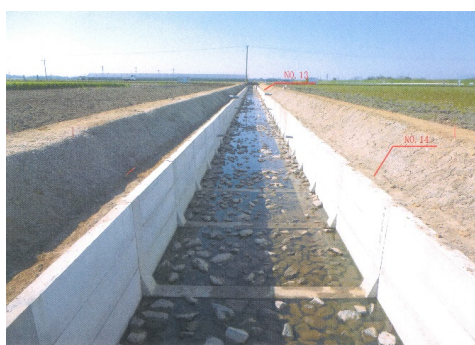
集落基盤整備事業排水路工事
