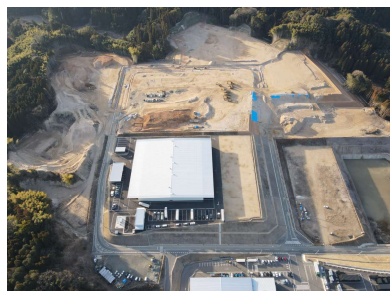
産業団地造成工事の様子
