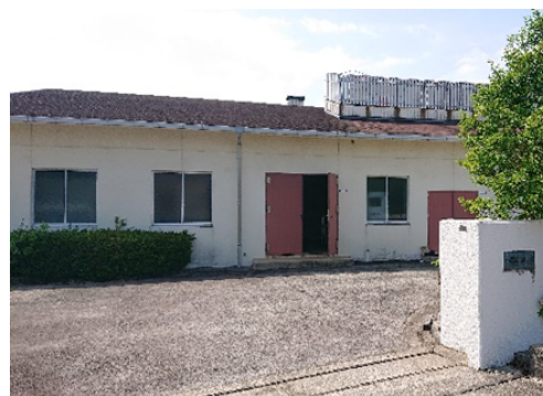
岱明汚水中継ポンプ場
