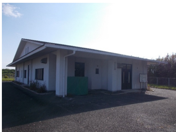
横島地区処理場
