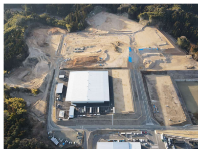
産業団地造成工事の様子
