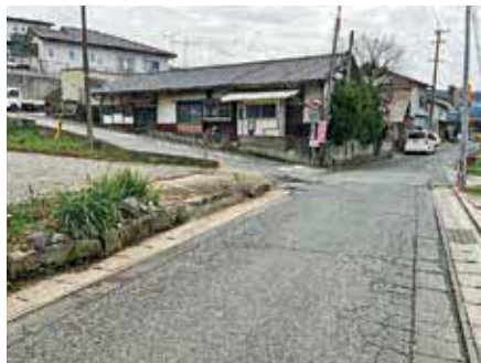
▲改良を予定している県道一号線の交差点
