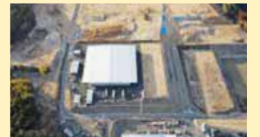
産業団地造成工事の様子
