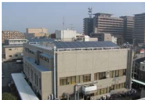
太陽光発電 (上下水道局別館)
