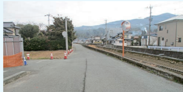
▲中学校側から見た道路
