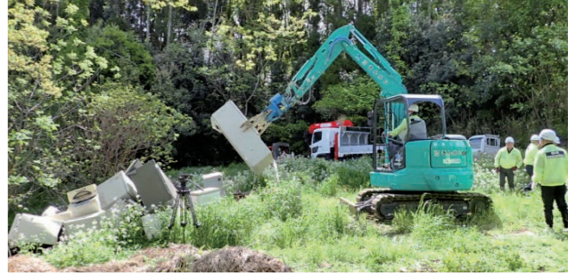
▲不法投棄物の撤去の様子
