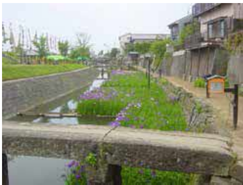
(写真) 裏川筋の石垣と桁橋 (高瀬)
