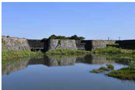
(写真) 六枚戸樋門（大浜・横島町）
