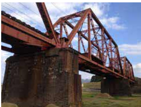
(写真) 高瀬川鉄橋 (高瀬)
