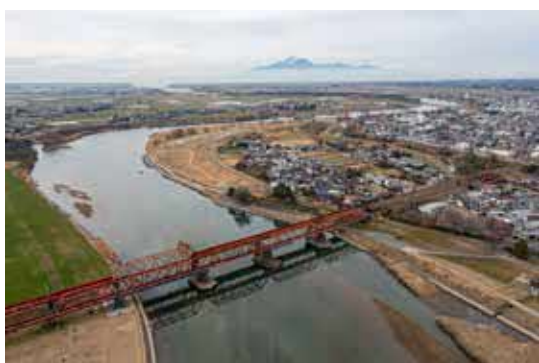
(写真) 熊本藩高瀬米蔵跡と高瀬鉄橋（高瀬）
