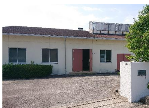
岱明汚水中継ポンプ場
