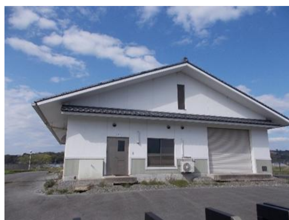
尾田川左岸地区処理場
