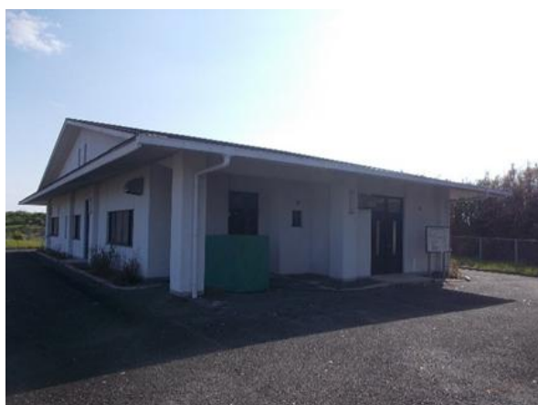
横島地区処理場
