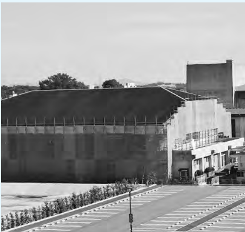
▲早急な復旧工事を7月に行なった勤労者体育センター
