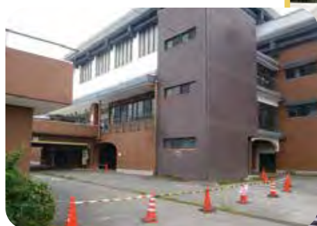
被災した天水体育館 (現在修繕のため調査中)
