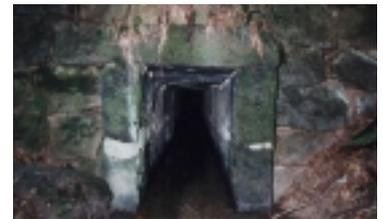
築地川の上流から浮田の上の池への830mにも及ぶ取水溝(1852年完成)。
