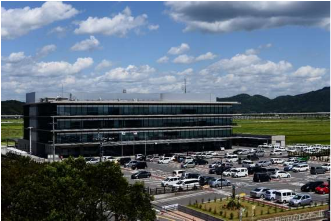
平成 27 年 1 月 5 日から業務を開始した市役所新庁舎
