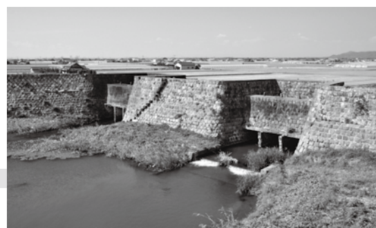
旧玉名干拓施設の中の六枚戸 （末広開東三枚戸樋門と西三枚戸樋門） 明治時代に築造され、昭和の国営干拓が完成するまで、農地を守りつづけた。
