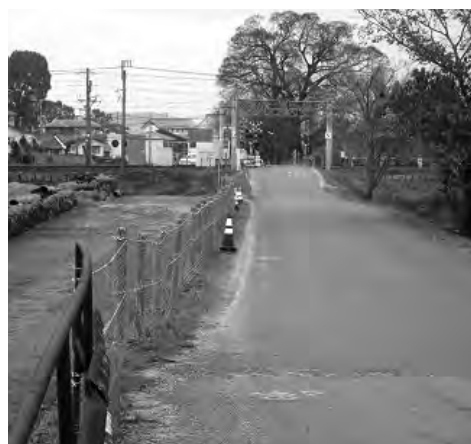
▲道路拡幅の工事が進む砂天神踏切付近
