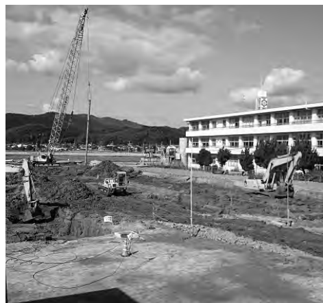
▲着々と進む玉陵小学校校舎建設
