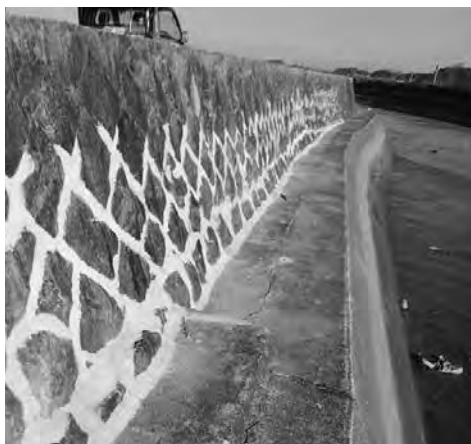
▲漏水場所の目地工事が済んだ唐人川堤防
