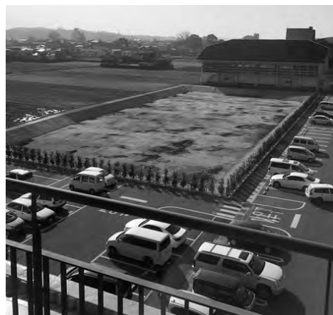
▲市役所南側調整池(3,159㎡)
