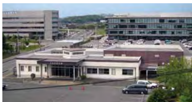
▲会議室棟は今後も使用します
