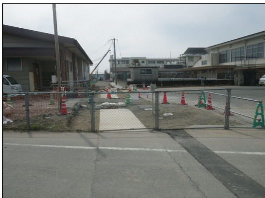
玉陵中学校校敷地内水路工事
