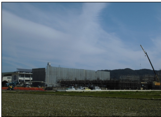
建設工事中の玉陵小学校校舎
