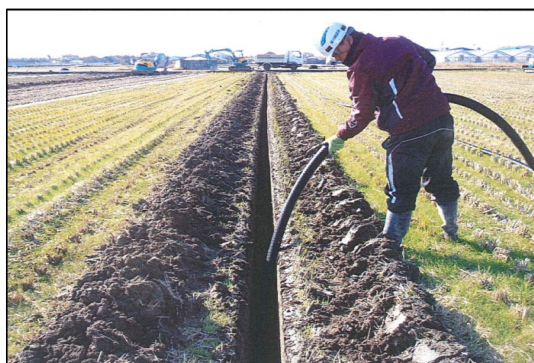
暗渠排水埋設状況
