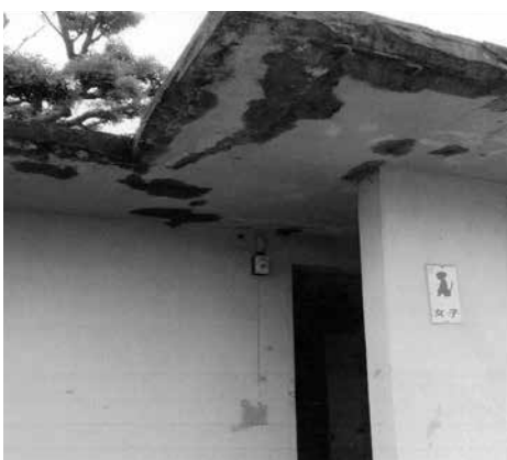
▲改修予定の岱明中学校の屋外トイレ
