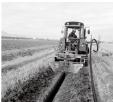
▲暗渠事業の施工風景
