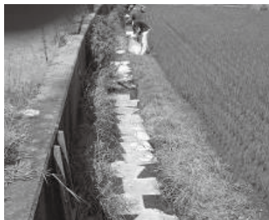
▲吸着マットによる流出油の回収作業
