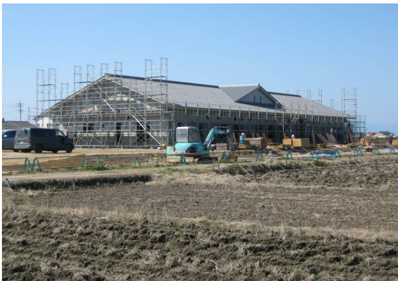
建設中の横島町大開地区汚水処理場
