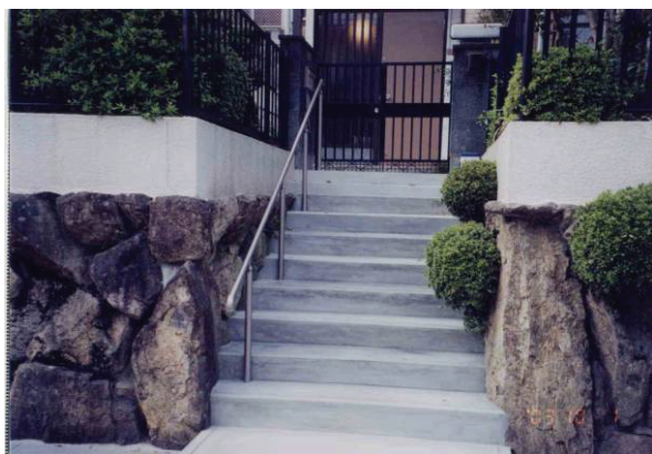
玄関への手すり設置
