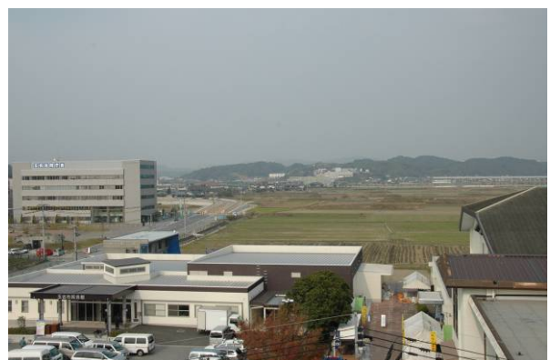
新庁舎建設予定地周辺
