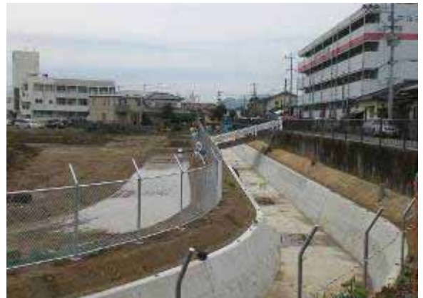
岩崎導水路改良工事
