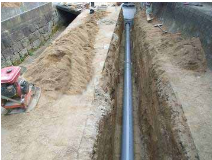
玉名汚水枝線管路工事
