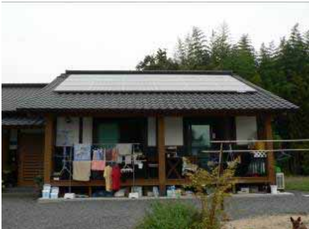
市内における太陽光発電システムの設置例
