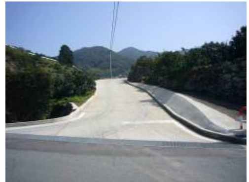
道路の拡幅工事完了後
