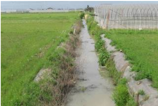
栗の尾地区内排水路
