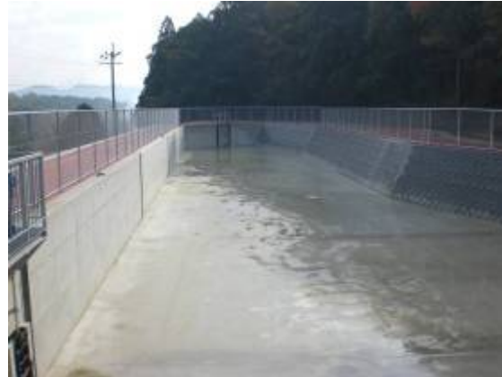
石貫3区ため池
