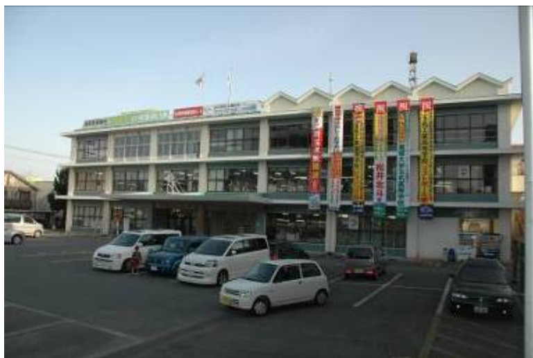
建築後50年を経過した本庁舎
