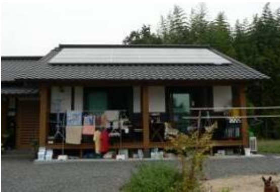
市内における太陽光発電システムの設置例
