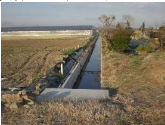
団体営栗の尾地区排水路工事
