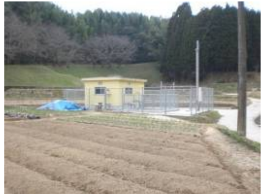
石貫3区ポンプ場
