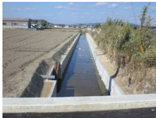
県営六十丁地区排水路工事
