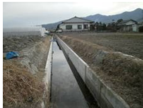
受免地区排水路工事
