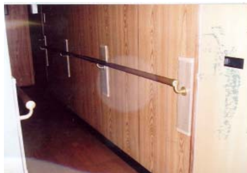
廊下手すりの設置
