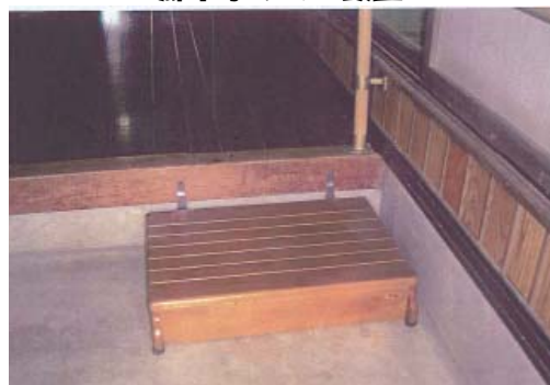
玄関踏み台設置による段差解消
