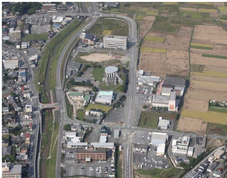
新庁舎建設予定地周辺
