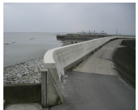
県営海岸保全施設整備事業
