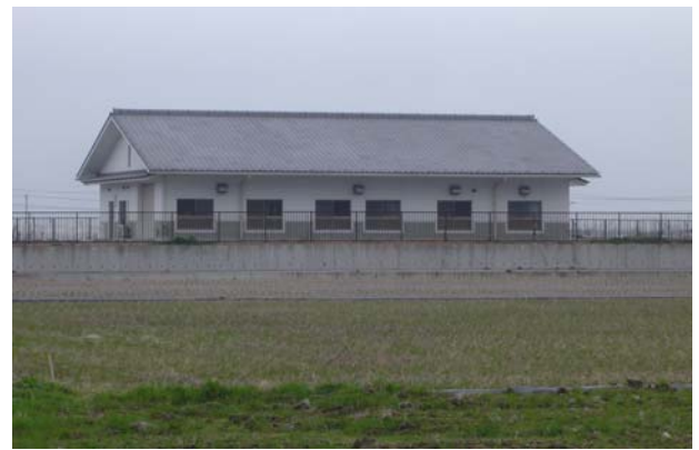
尾田川左岸農業集落排水処理場
